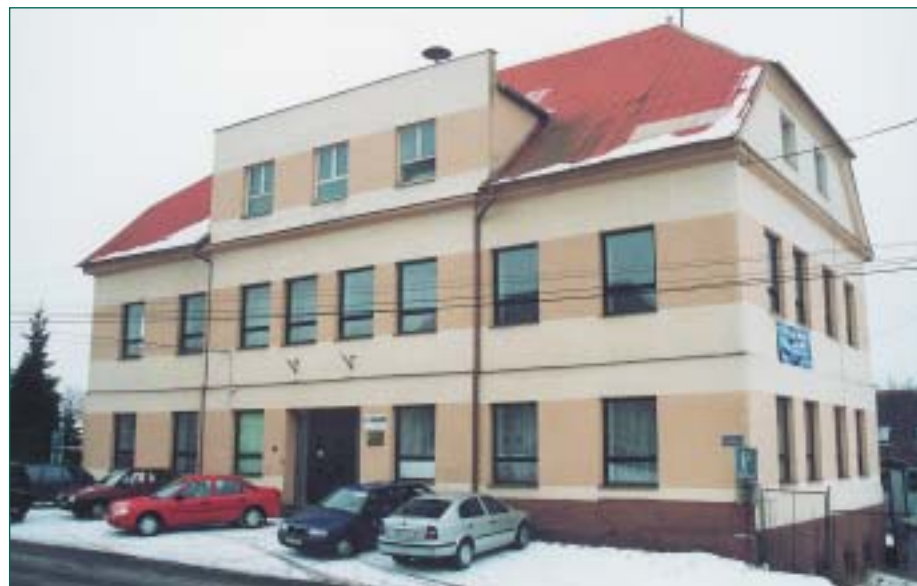
Budova lesní správy Česká Lípa
