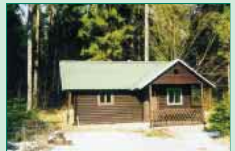
Opravený přístřešek u bývalé lesní školky LS Vodňany
