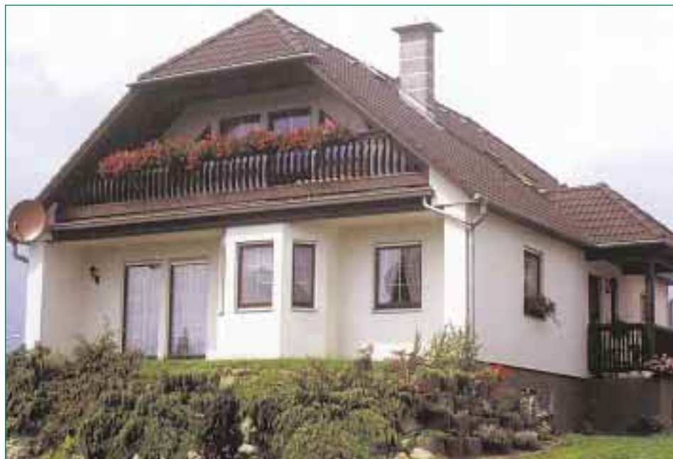
Dům s hrázděnou dřevěnou konstrukcí sendvičového typu
