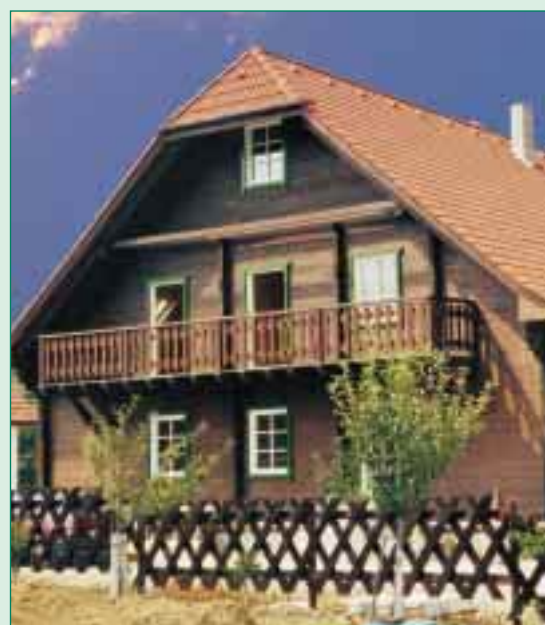
Příklady použití dřeva při stavbě domů:
