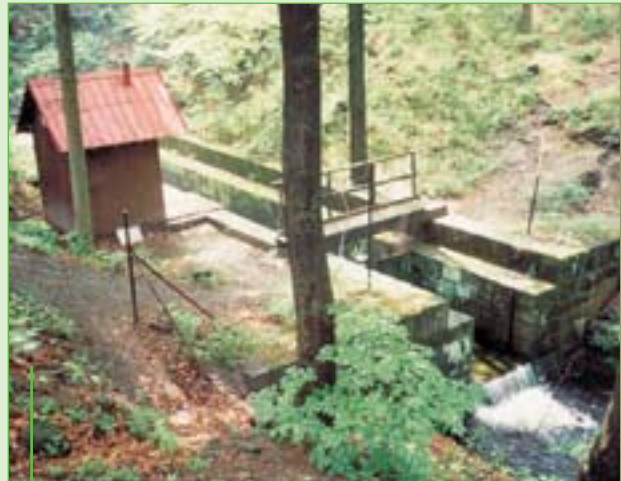
Uzávěrový profil s limnigrafickou budkou na povodí Malá Ráztoka
