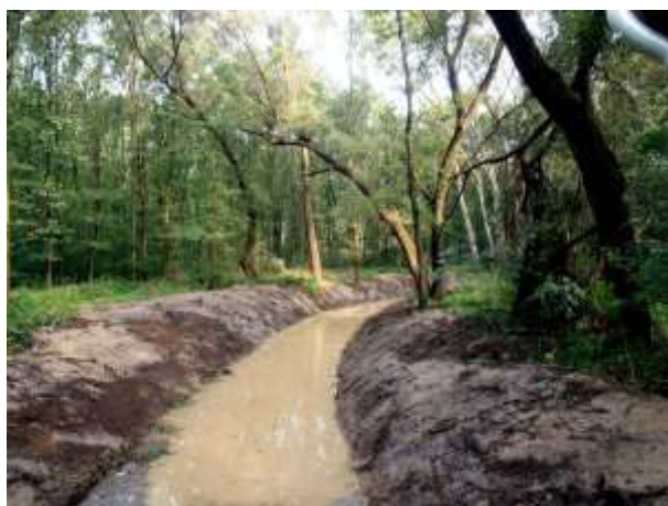
pohled na prohloubený úsek kanálu
