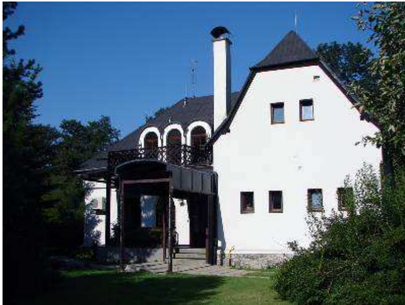
Sídlo lesní správy Šternberk
