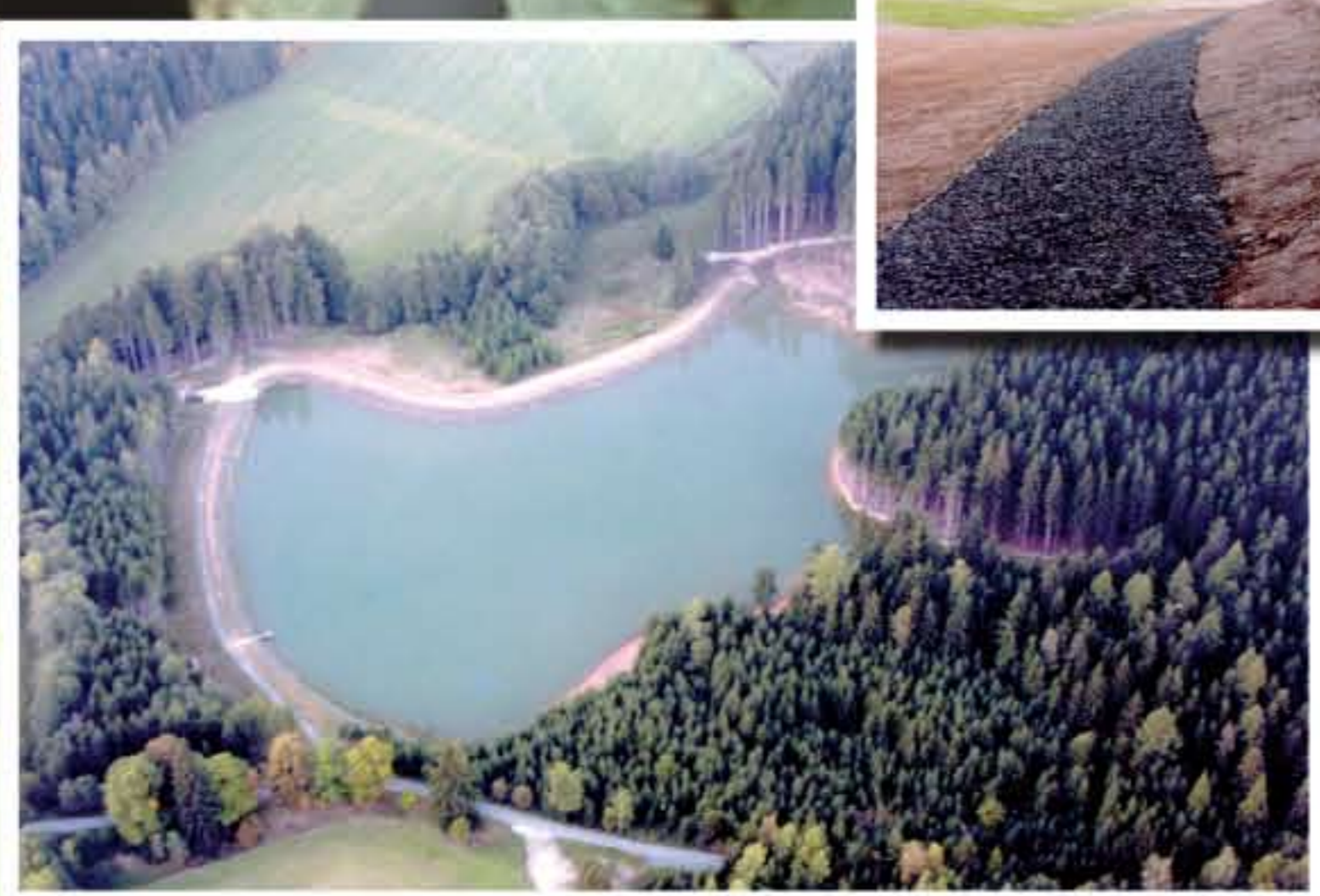
Výstavba nového vodního díla - r. 2002. Retenční nádrž U mlejna byla napuštěna v r. 2003. The construction of the new water resource - 2002. The "U mlejna" retention reservoir was filled in 2003.
