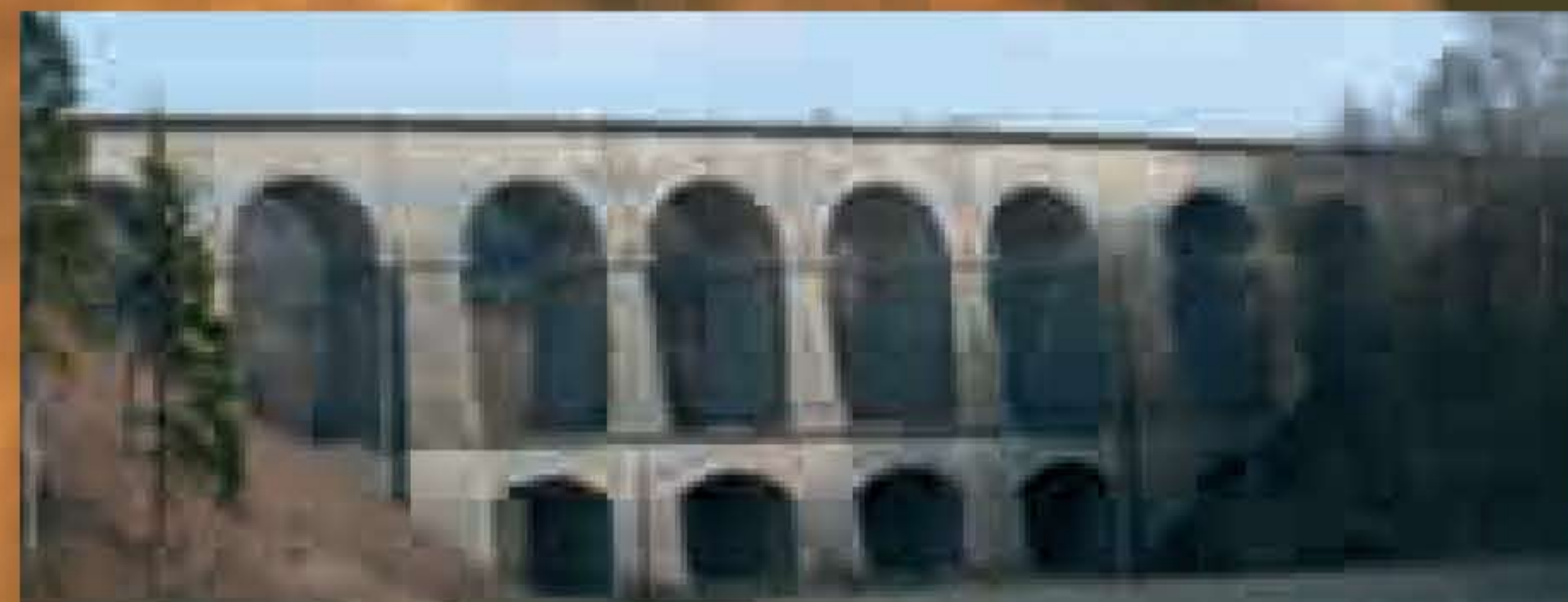
Viadukt v Radostině
