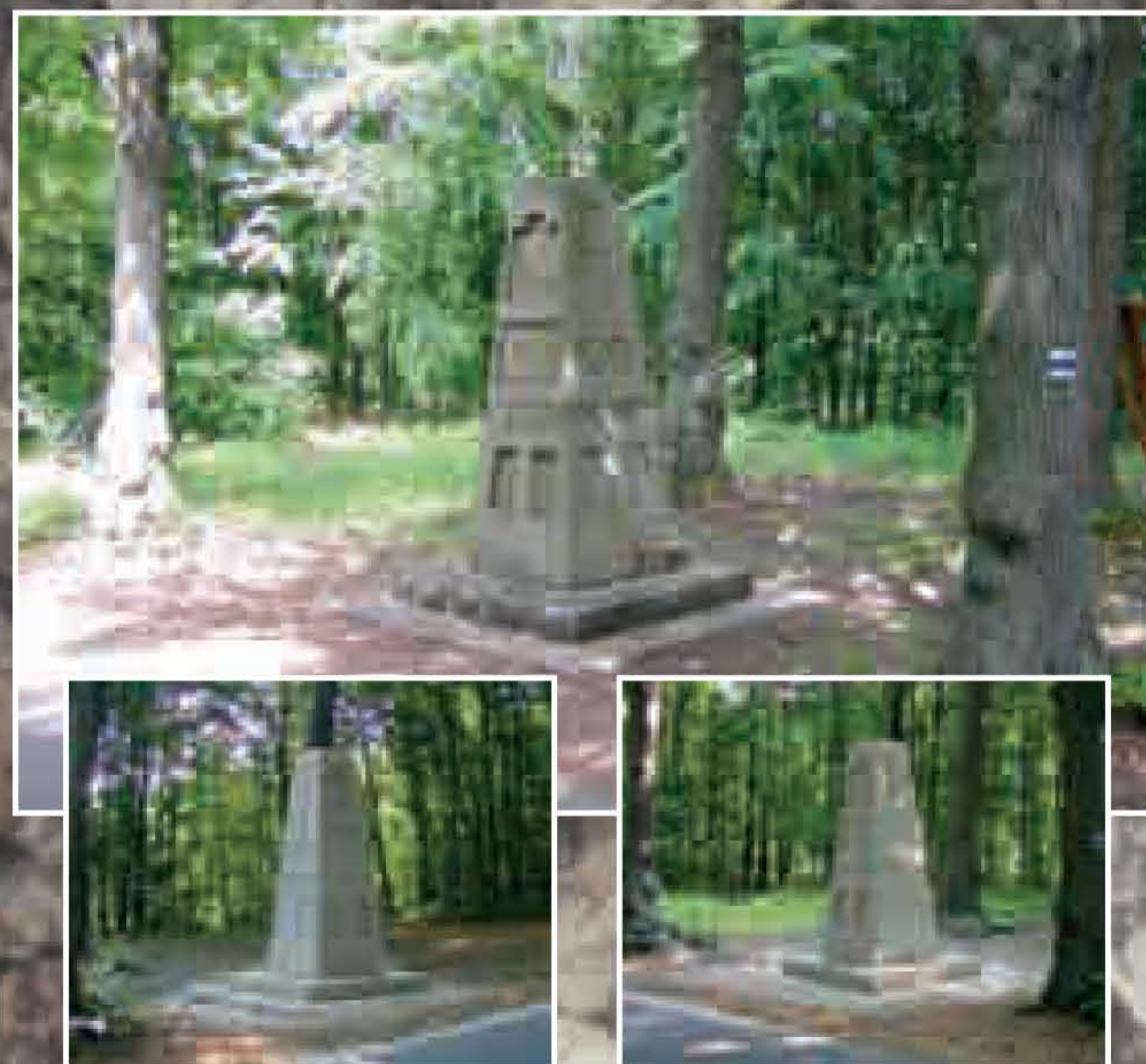
Žulová pyramida před renovací a po renovaci
