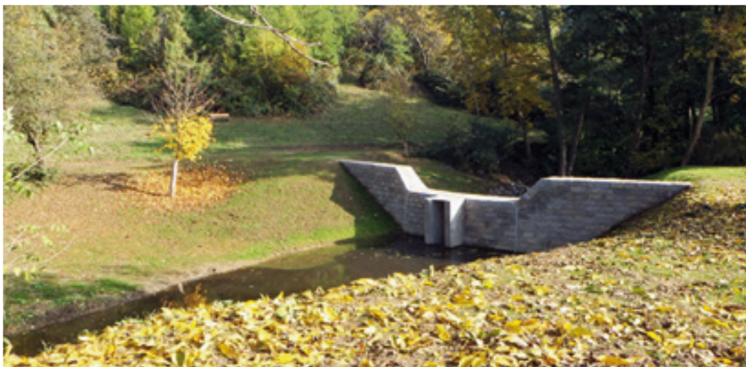
Úprava retenční nádrže Horky na Čeložnickém potoce na Kyjovsku.
