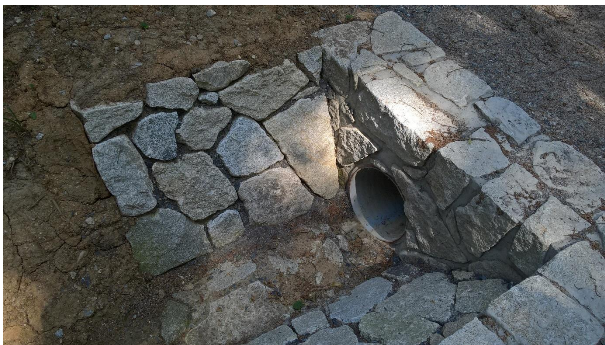
LS Bučovice (lesní cesta 1L K Lavečkám) – lesní cesta po rekonstrukci (ukázka propustku)
